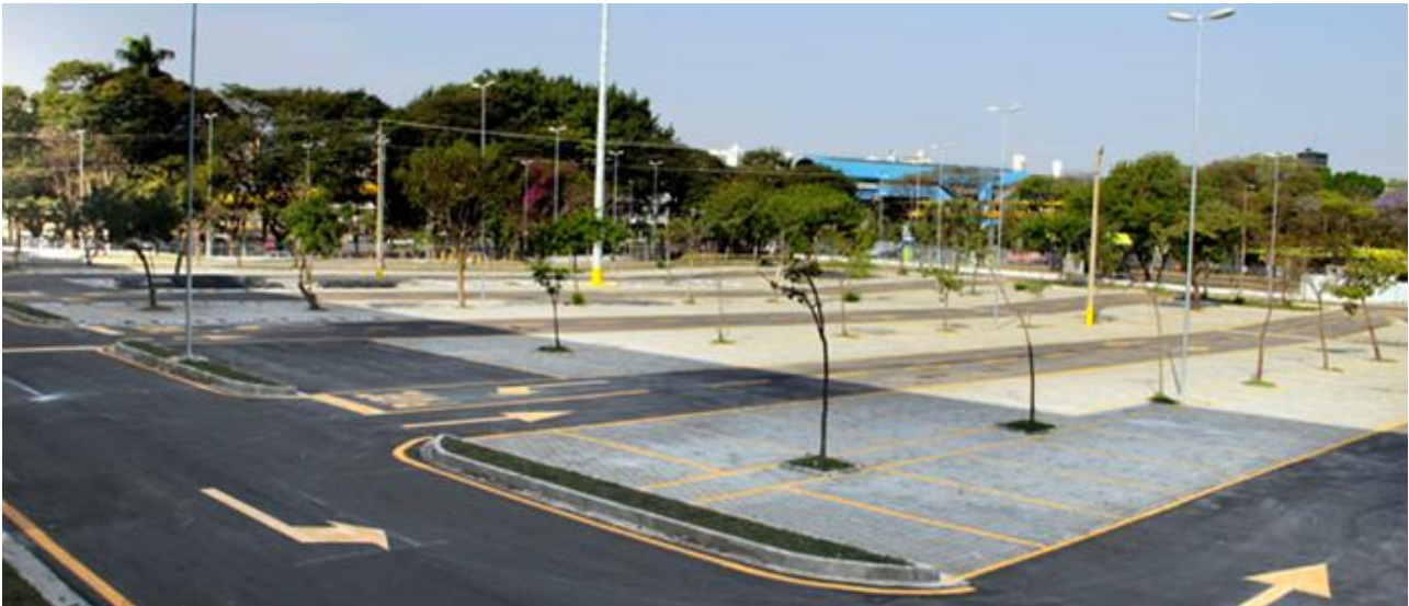
O piso natural drenante impediu a formação de poças de água mesmo durante chuvas intensas (foto: divulgação/Oterprem)
